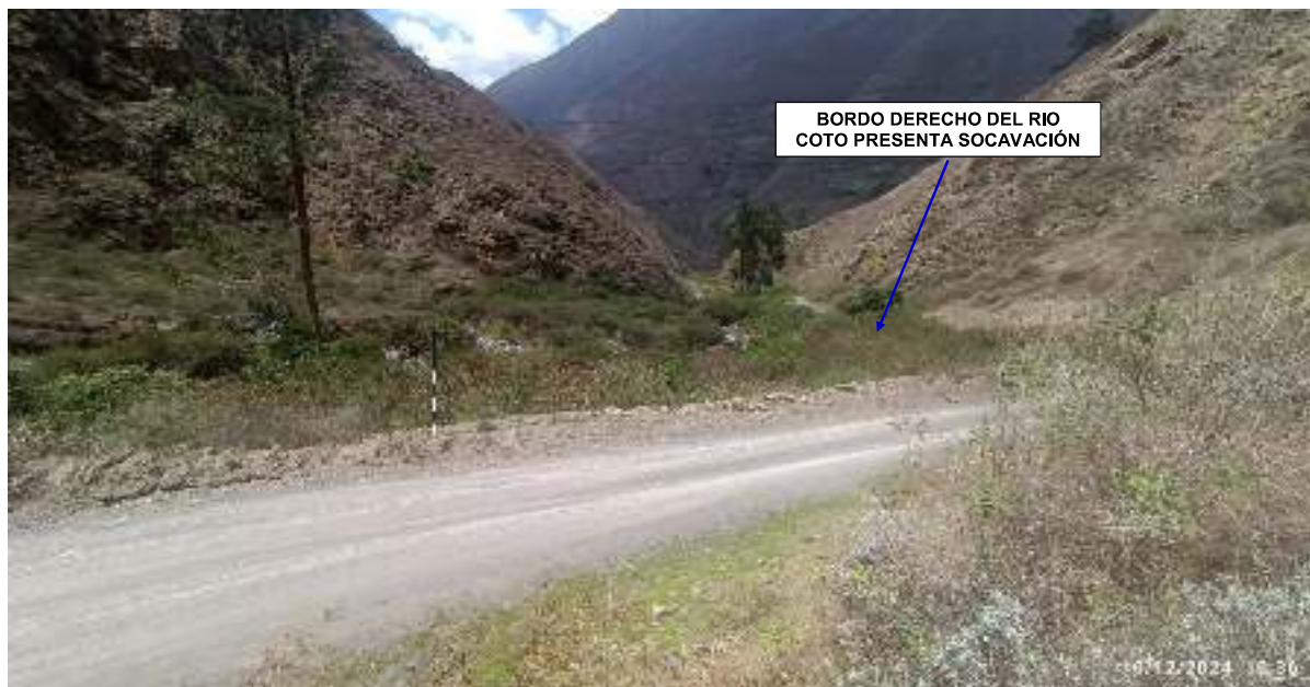
FIGURA N°03: RIO COTO CON BORDO EN EL MARGEN DERECHA AFECTADA HASTA LA TROCHA CARROZABLE, PONIENDO EN PELIGRO A SOCAVAR LA VÍA.
