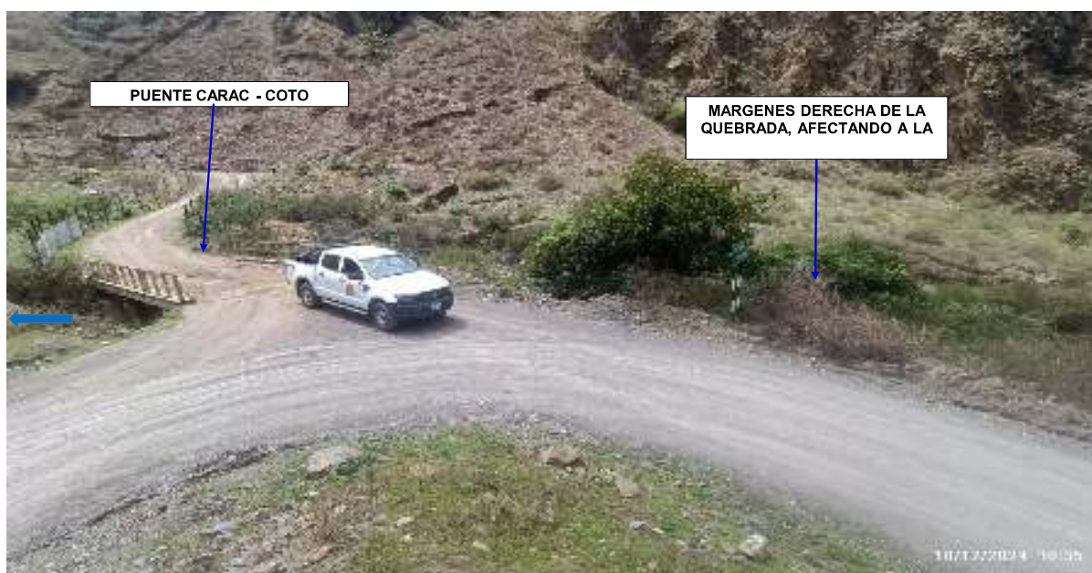
FIGURA N°02: A LA MARGEN DERECHA DEL RIO COTO SE ENCUENTRA LA TROCHA CARROZABLE SIENDO AFECTADO POR LA EROSIÓN DEL CAUDAL Y SEDIMENTACIÓN DEL RIO.
